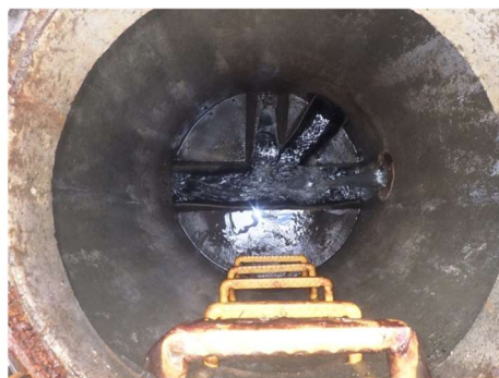
②平成4年建設 圧送後マンホール状況
